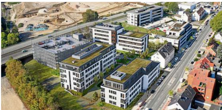
So soll es an der Alten Wittener Straße in Laer in zwei Jahren aussehen. Die Harpen Unternehmensgruppe baut auf 10.200 Quadratmetern drei weitere Bürogebäude und ein Parkhaus, den Office-Campus 51/7.
